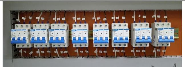
6. Las salidas de las protecciones eléctricas se conectarán hacia las entradas del Contactor-Relé Térmico (R, S, T) y las salidas del relé térmico deberán atravesar por los TC's.
