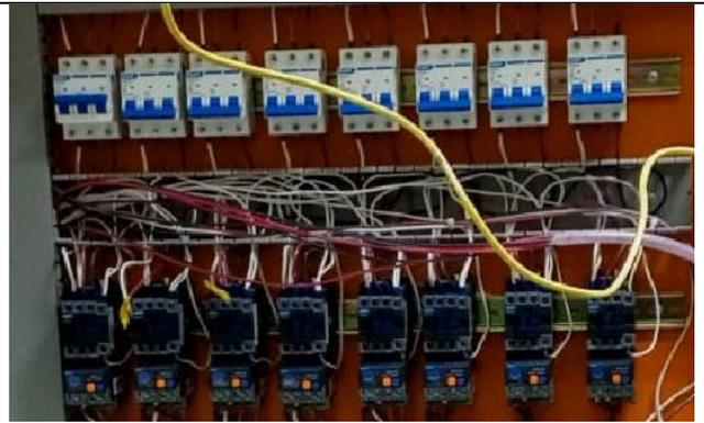
5. Desde la barra de distribución se suministrará energía de manera ordenada e individual, la conexión de las tres fases (R, S, T) en cada una de las entradas de las protecciones del circuito inductivo (breaker) y las salidas a los contactores eléctricos.
