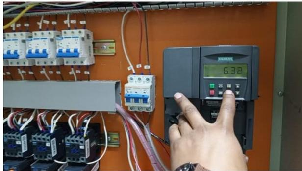
Figura 9.1 Programación del Variador de Frecuencia.
