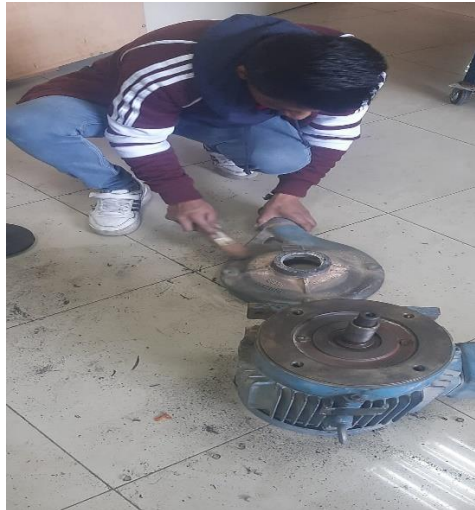
Figura 4.6. desmontaje de la voluta.
