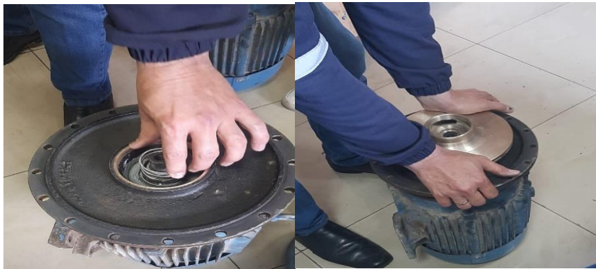
Figura 4.10. instalación del impulsor y el sello mecánico.
