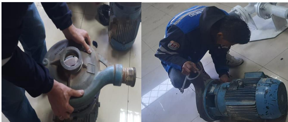
Figura 4.11. instalación de la voluta de la bomba.
