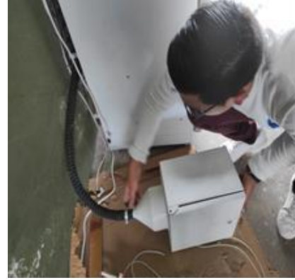
Figura N°08 Acoplar el sistema de calefacción
