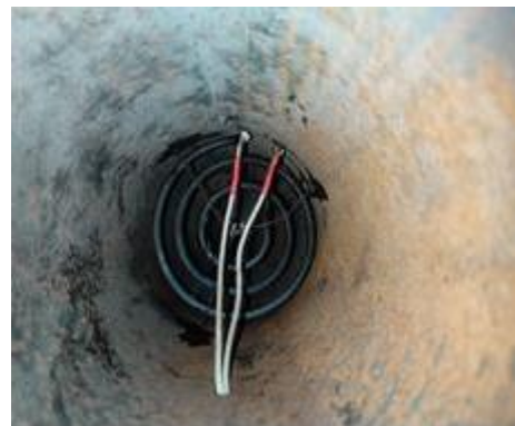
Figura N°04 Instalación de la Niquelina Eléctrica
