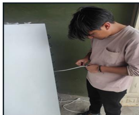
Figura N°06 Conexión del cable de alta temperatura
