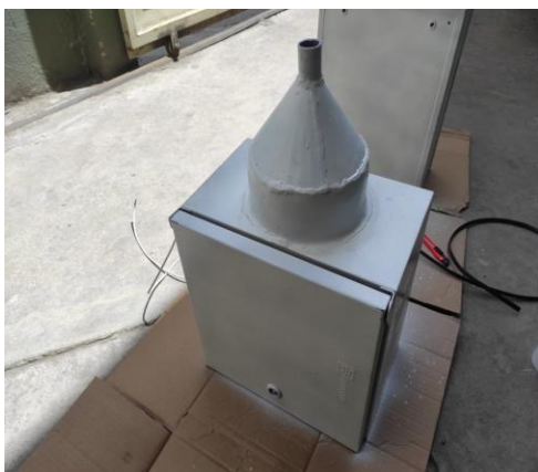
Figura N°05 Pintado del sistema de calefacción
