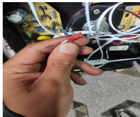
Figura N°14 Conexión del cableado eléctrico
