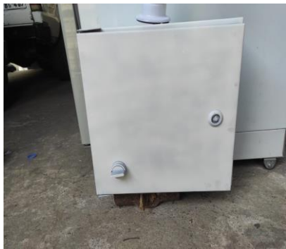
Figura N°09 Preparación del sistema de humedad
