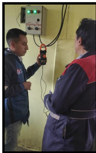
Figura 3.38: Revisión de conexiones del equipo de refrigeración
