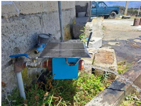
Figura XII. 4: Medidor inteligente instalado en el punto más lejano a la junta de agua
