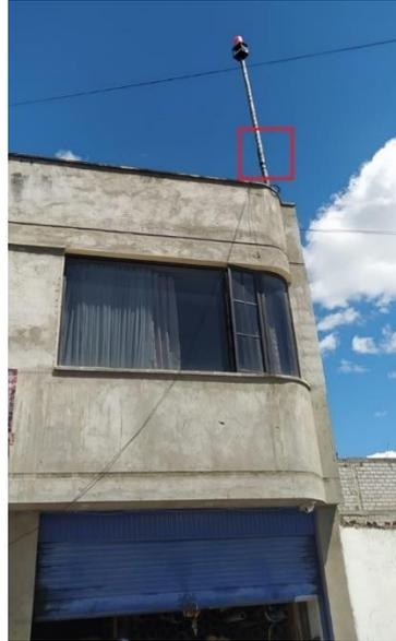
Figura XII. 6: Antena de Gateway ubicada en la parte superior de la junta de agua
