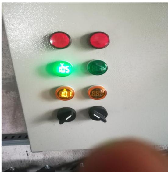
**Figura 5. 3.** Medidor de voltaje y corriente.
