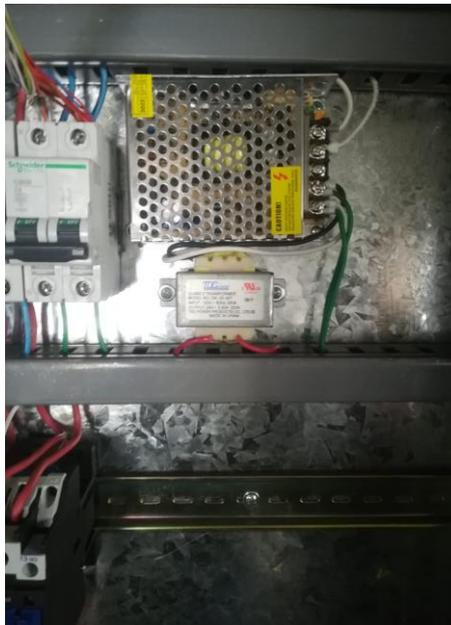
**Figura 5. 1.** Termomagnético y transformador de 24-12 V.
