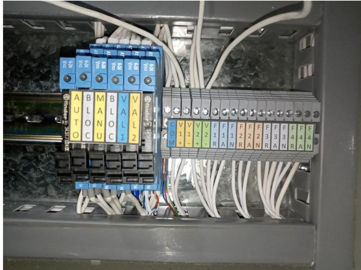
**Figura 5. 4.** Relés tipo interfaz para control del sistema.
