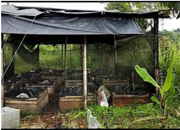
Fotografía 1. Limpieza del terreno
