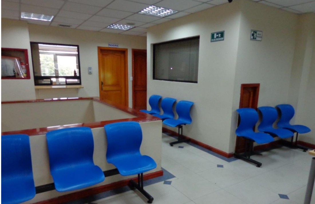
Ilustración 5.3 Evidencia de pasillo en la Dirección Técnica no hermetizado y que está climatizado
