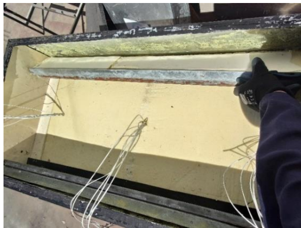
Fig. 28. Instalación del aislante térmico en las paredes del colector
