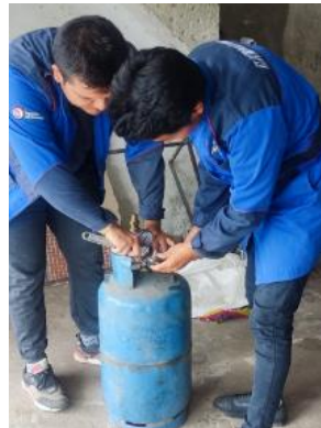
Figura 8. Instalación de válvula Gas Keelgas
