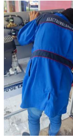
Figura 7. Mantenimiento del equipo de extracción y pasteurización de biogás II.
