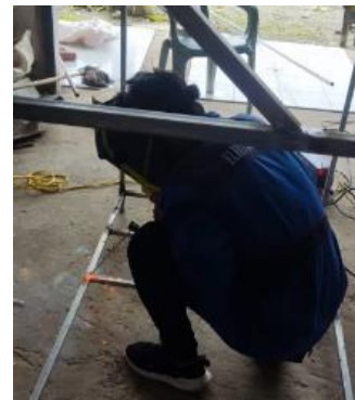
Figura 10. Construcción del módulo del sistema híbrido II.
