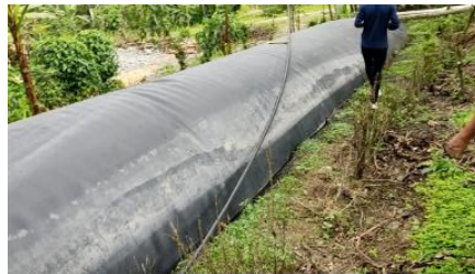
Imagen 20. Biodigestor recinto Villaverde
