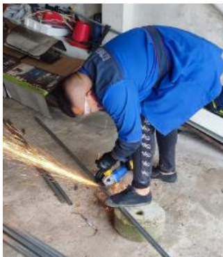
Figura 9. Construcción del módulo del sistema híbrido
