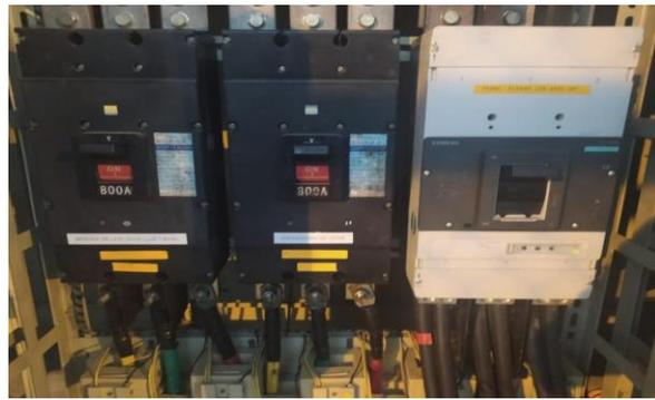
*Figura 14 Disyuntores del Tablero de Distribución*
