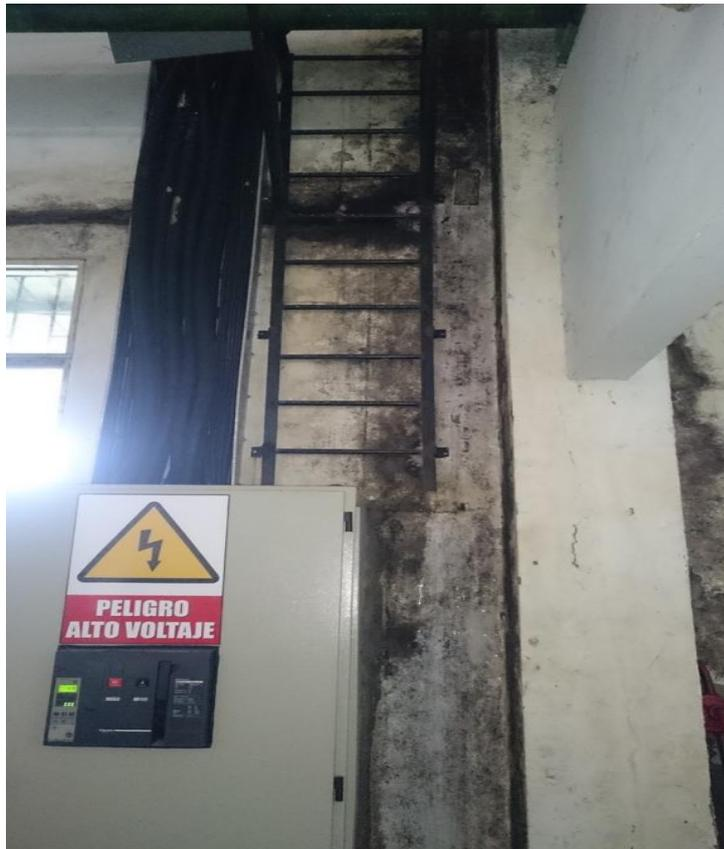
*Figura 16* Canalización del sub-tablero
