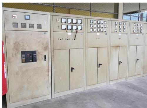
**Figura 13** Tableros de distribución principal en baja tensión
