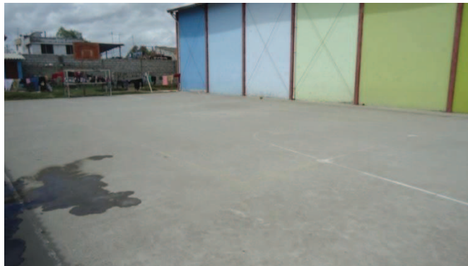
ZONA SEGURA 4. Ubicado al frente del centro de computación
