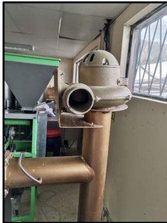
Figura 36. Encendido del extractor.
