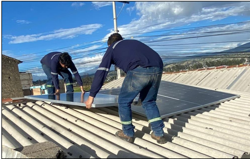
Figura 4.20 Colocación de los módulos fotovoltaicos
