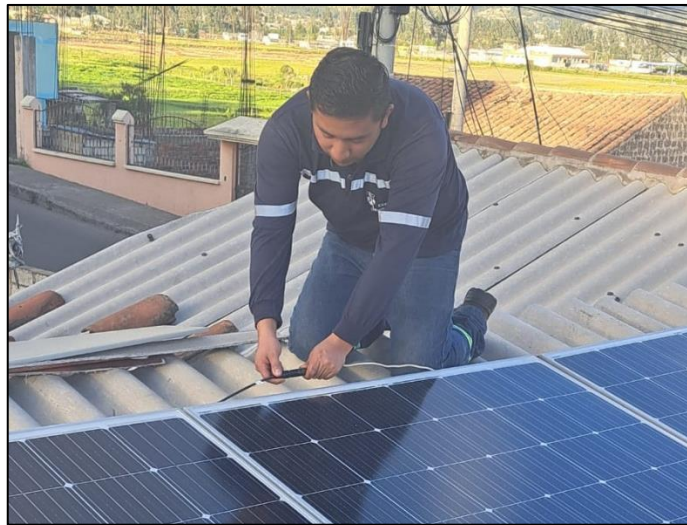
Figura 4.21 Conexión de los módulos fotovoltaicos
