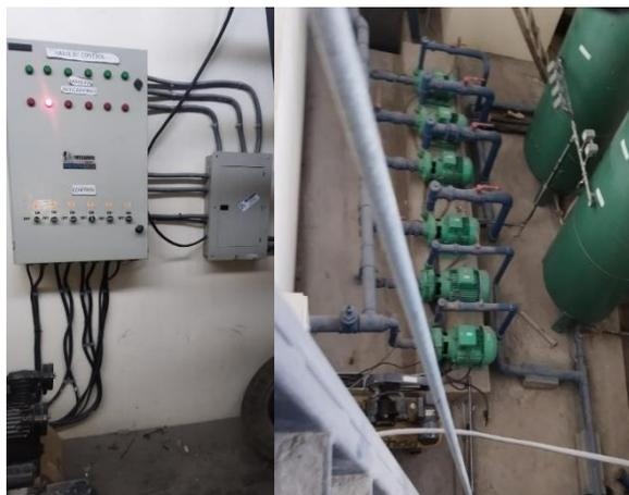
Figura 4.3 Gabinete principal de alimentación al cuarto de bombas y cuarto de bombeo
