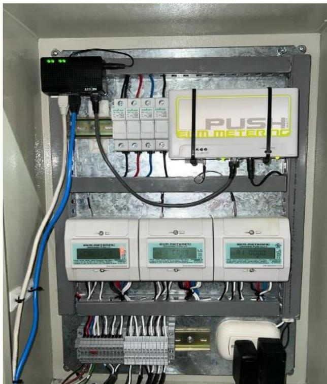
Figura 4.7 Sistema de medición inteligente.
