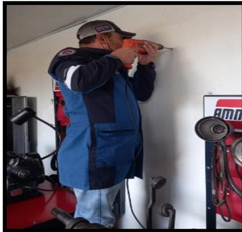
*Fig. 1 Realización de los orificios con la ayuda de un taladro*
