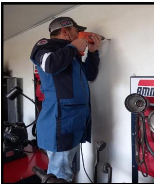
*Fig. 4. 24 Señalar en la pared donde van ir los orificios del gabinete*
