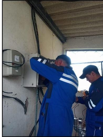
**Anexo 10.** Conexiones trifásicas de las bombas centrifuga MARK GRUNDFOS MODELO DVR 10 DE 7.5 Y MODELO DE DVR 15 DE 11 KW.
