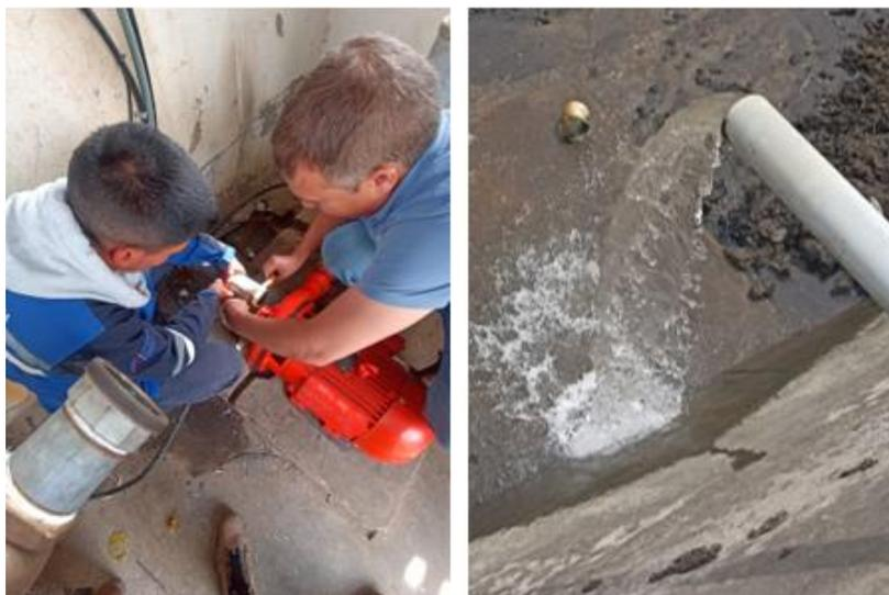
Figura 4.12 Conexión de la tubería en serie de las bombas
