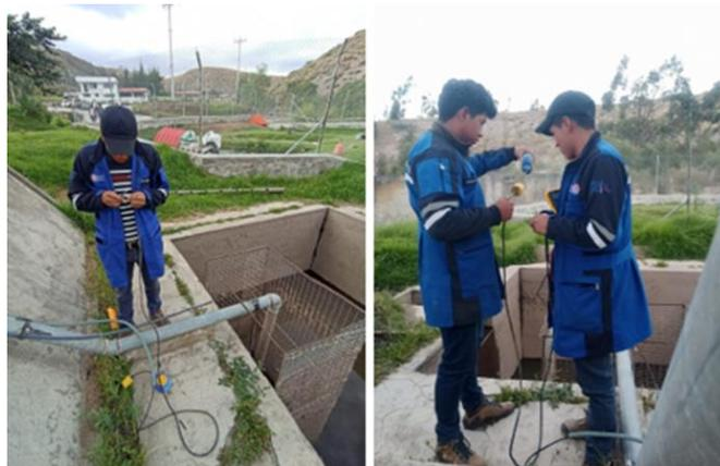
Figura 4.10 Verificación del estado del flotador
