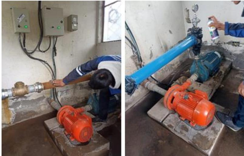
Figura 4.13 Verificación de posibles fugas
