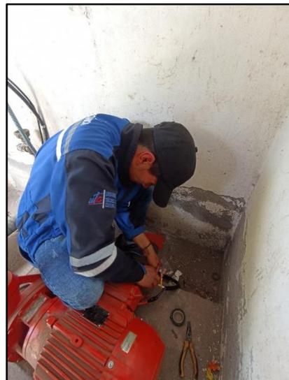
**Anexo 11.** Recolección de datos de la bomba centrífuga MARK GRUNDFOS MODELO DVR 10 DE 7.5 Y MODELO DE DVR 15 DE 11 KW.
