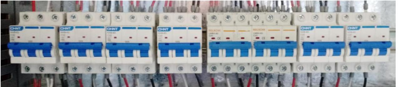
*Figura 4. Protección de contactores.*
