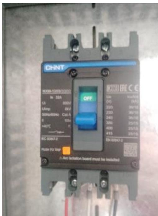
*Figura O.1. Instalación de protección principal.*
