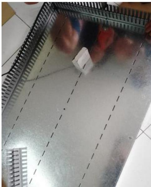
*Figura Ñ.1. Instalación de canaletas.*
