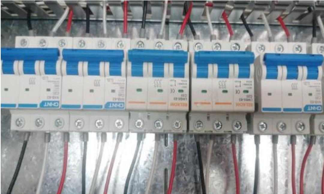
*Figura T.1. Instalación de protecciones para los contactores de activación de contactores.*
