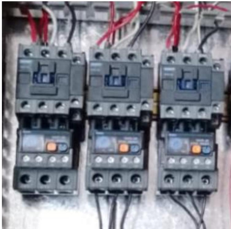
*Figura U.1. Instalación de contactores CHNT NXC-32 de arranque estrella – triángulo.*
