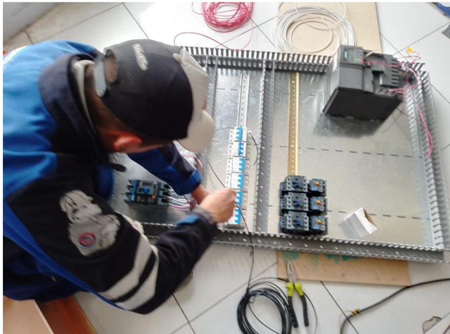
*Figura C.4. Conexión de protección principal.*
