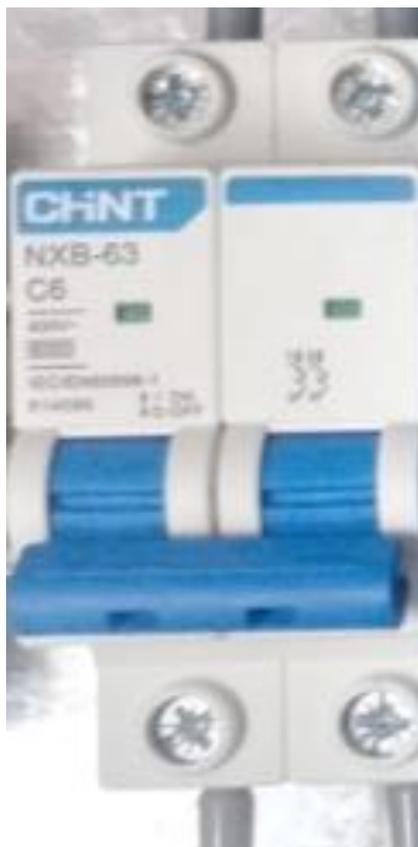
*Figura Q.1. Protección de PLC.*
