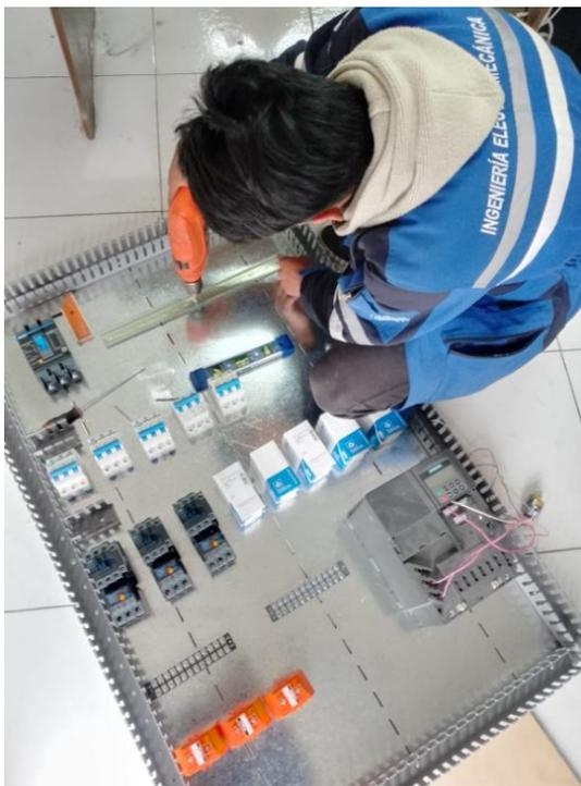
*Figura B.1. Instalación de Riel din.*
