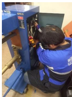
Figura 4.1 Medición de resistencia de bobinados
