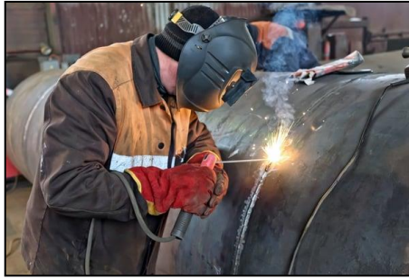
Figura 2.1 Proceso de soldadura con electrodo Fuente: [5]
