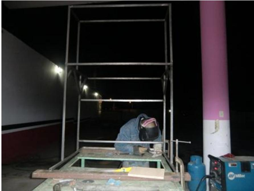
**Ilustración:** Ensamblaje panel de control y mesa Banco de Pruebas Control Neumático
