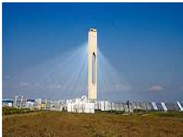
FIGURA 1.6. CENTRAL DE GENERACIÓN SOLAR TÉRMICA
