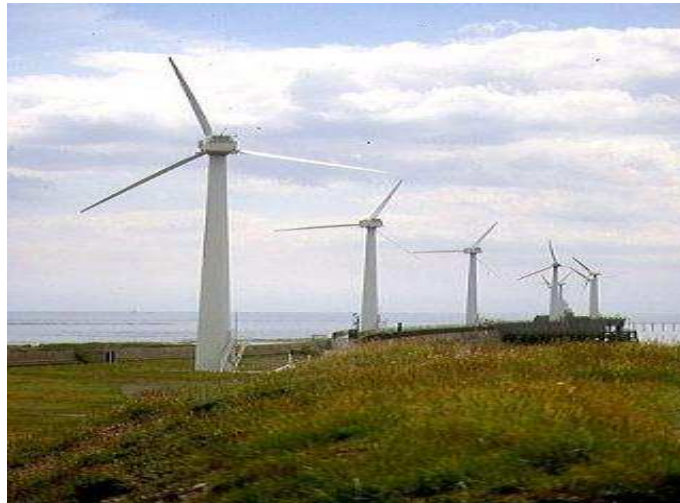
FIGURA 1.4. PARQUE DE GENERACIÓN DE ENERGÍA EÓLICA
