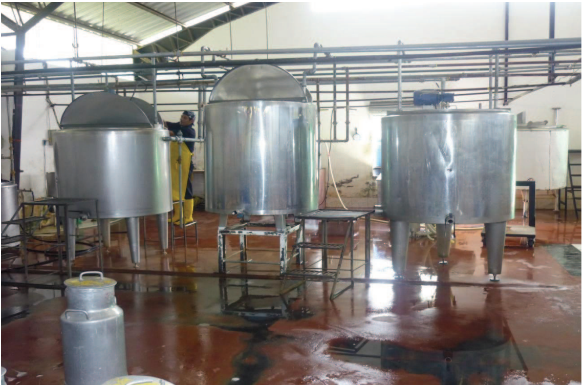
Tanques de enfriamiento
