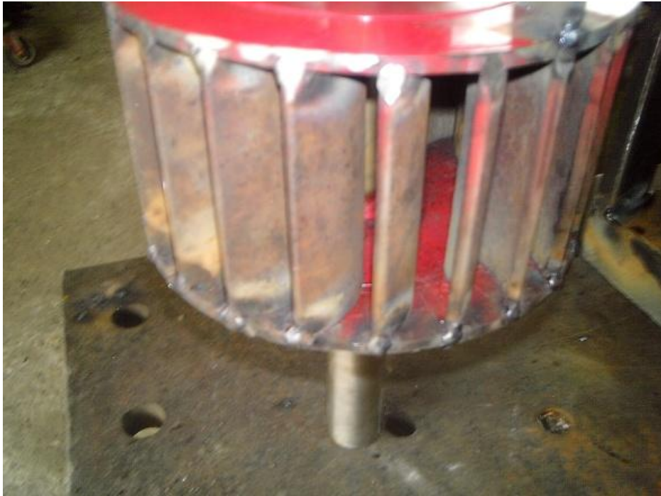
Soldadura de los álabes al rotor vista lateral inferior
