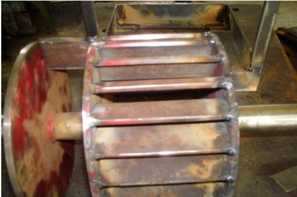
Soldadura de los álabes al rotor vista frontal
