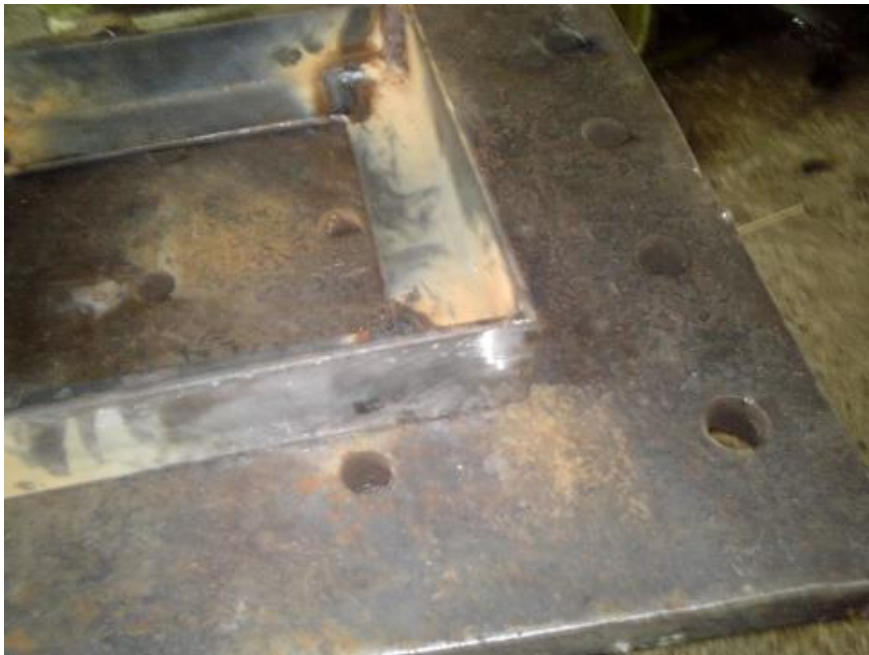
Construcción de la base de la turbina vista isométrica parte inferior
