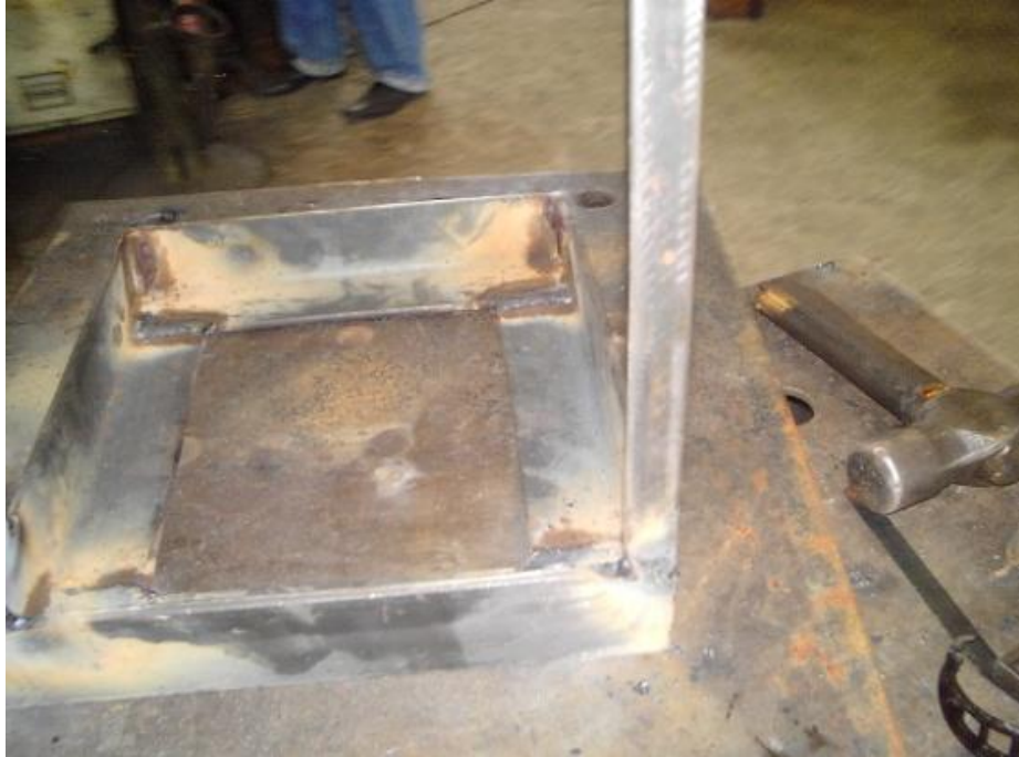
Construcción de la base de la turbina vista isométrica superior
