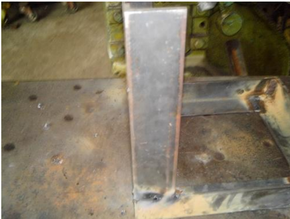
Construcción de la base de la turbina vista lateral
