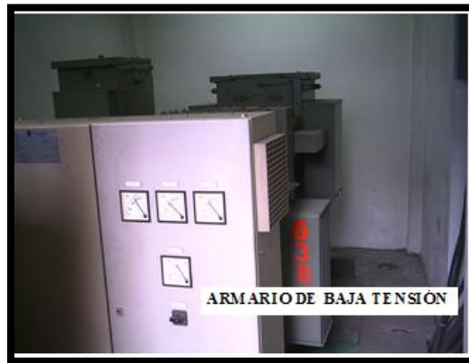
GRÁFICO N°3-7; ARMARIO DE BAJO VOLTAJE
