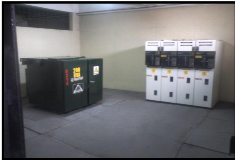
GRÁFICO N° 3-3; CÁMARA DE TRANSFORMACIÓN SUBTERRÁNEA
