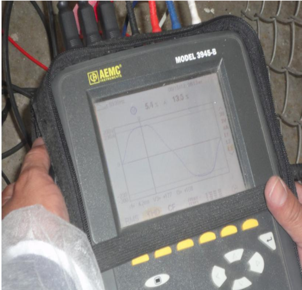
Figura 2.6. Conexión del analizador de energía eléctrica en el punto D.
