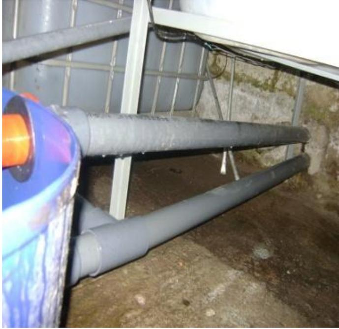
Figura. 3.23 Implementación de tubería hacia el tanque reservorio
