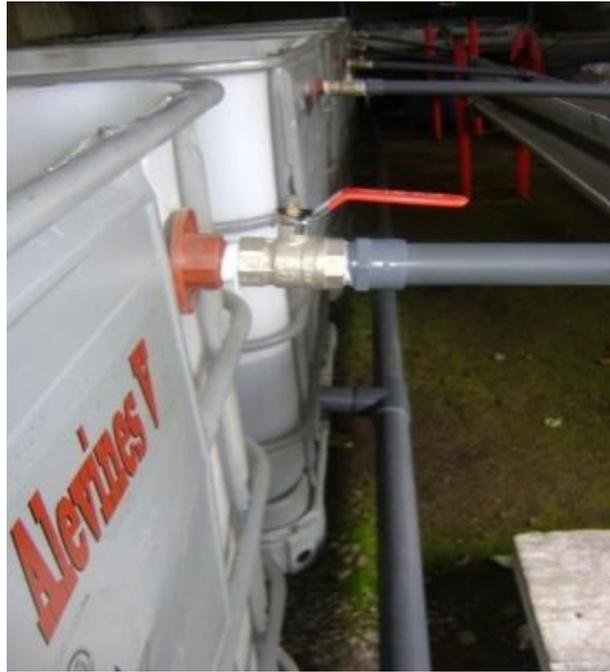
Figura. 3.28 Implementación de válvulas de desborde de tanques
