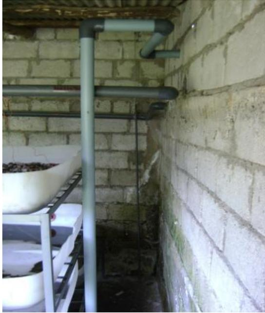
Figura. 3.21 Implementación de tubería de red de recirculación
