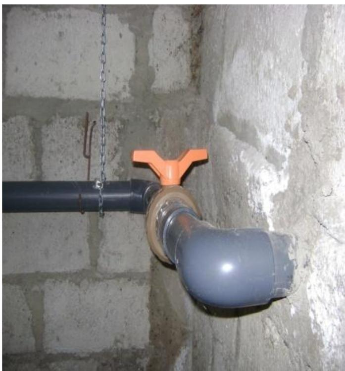
Figura. 3.25 Implementación de válvula principal de 2" de entrada de agua
