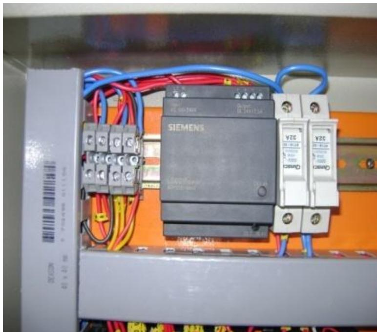
Fig. 3.40 Montaje de Fuente de alimentación y fusibles
