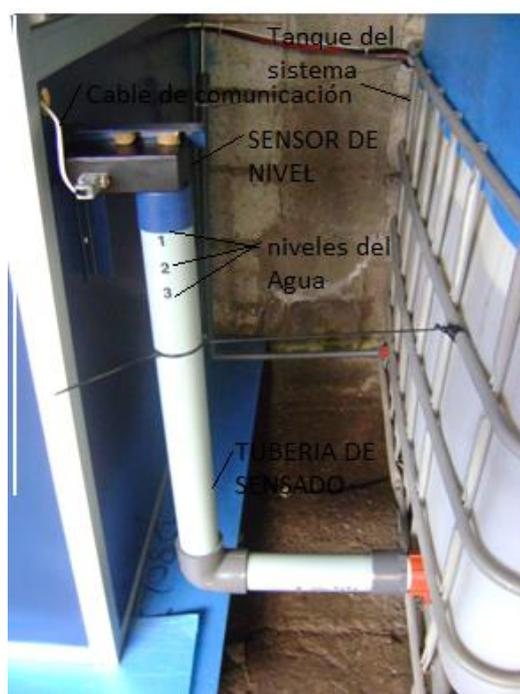
Fig. 3.35 Implementación de sensor de nivel en el sistema
