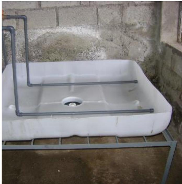
Figura. 3.20 Implementación de tubería en bandejas de eclosión
