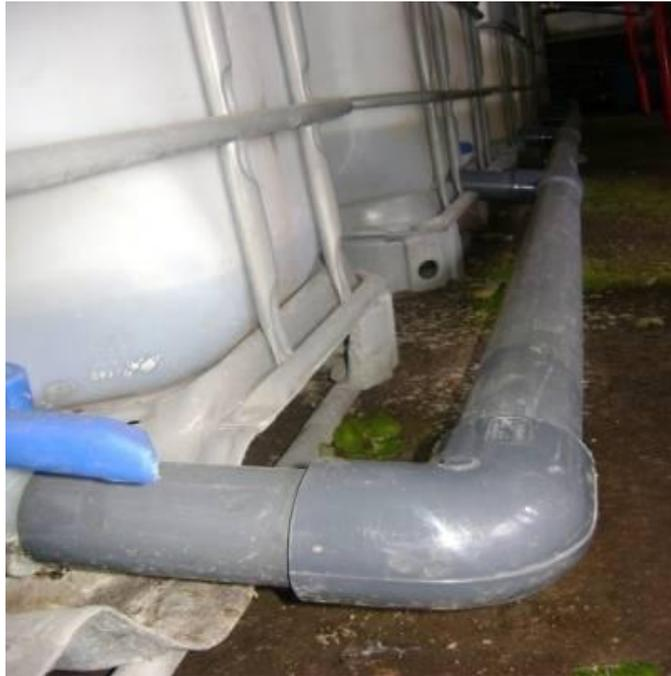
Figura. 3.19 Implementación de tubería principal y ramales de salida de agua de agua tanques
