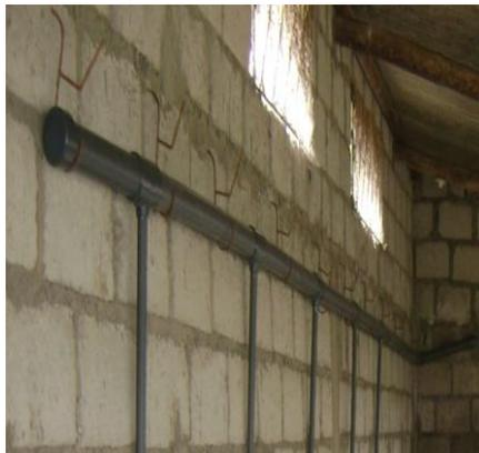
Figura. 3.18 Implementación de tubería principal y ramales de entrada de agua tanques
