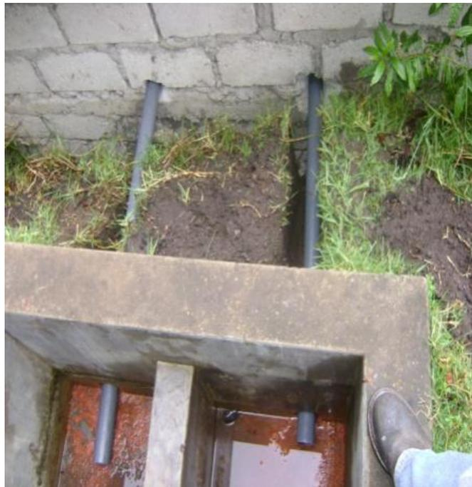
Figura. 3.24 Implementación de tubería en tanque distribuidor
