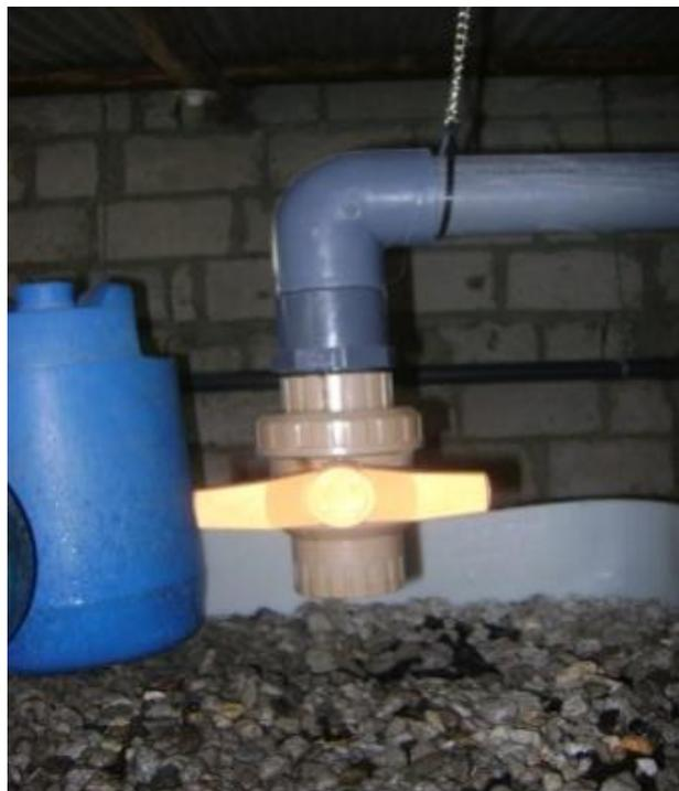
Figura. 3.27 Implementación de válvula de entrada a las bandejas de eclosión
