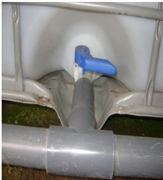
Figura. 3.29 Implementación de válvulas de desfogue
