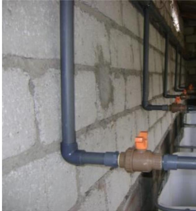
Figura. 3.26 Implementación de válvulas de entrada a los tanques de 1''
