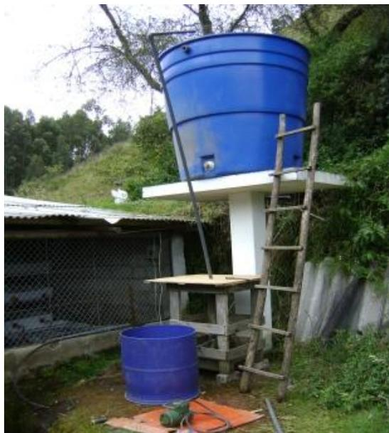
Figura. 3.16 Implementación de Tanque reservorio y tanque colector2
