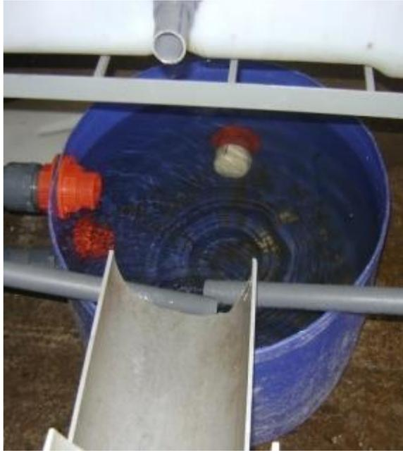
Figura. 3.15 Implementación de Tanque colector 1 para recirculación o desagüe
