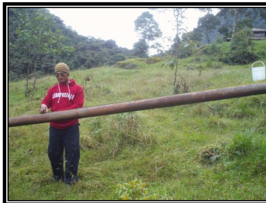
Fig. N° 3.11 IDENTIFICACIÓN DE LA TUBERÍA EN SITÚ
