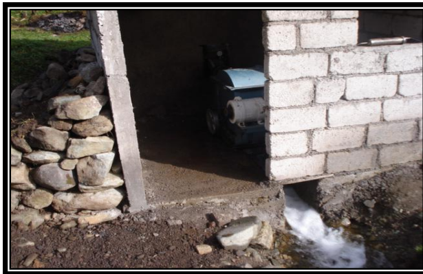
Fig. No. 3.25 Piso
