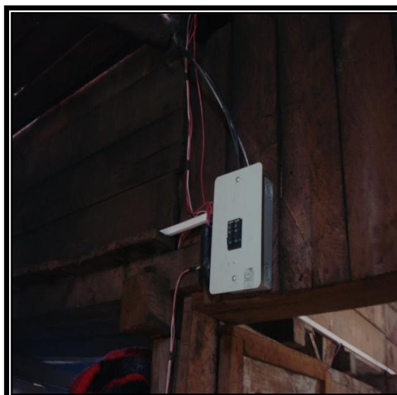
CAJA DE PROTECCION EN EL INTERIOR DE LA HOSTERIA
