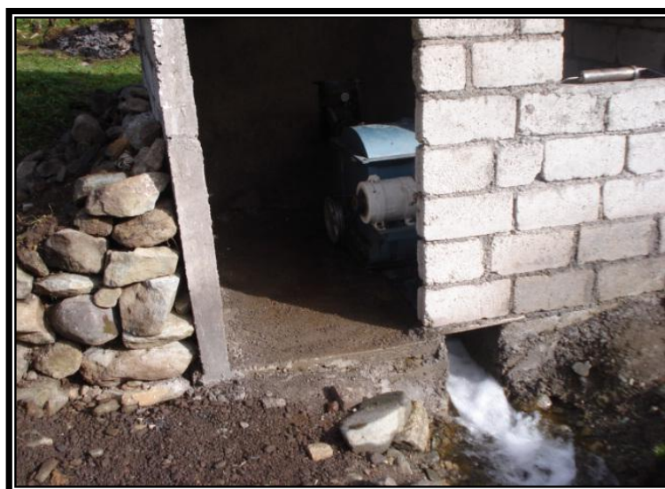
Fig. No. 3.24 Cimientos
