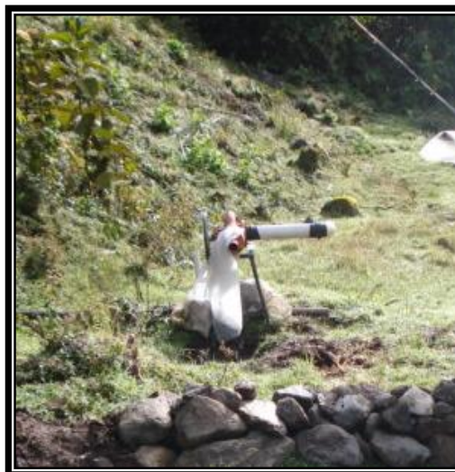
ANTIGUO SISTEMA DE GENERACION
