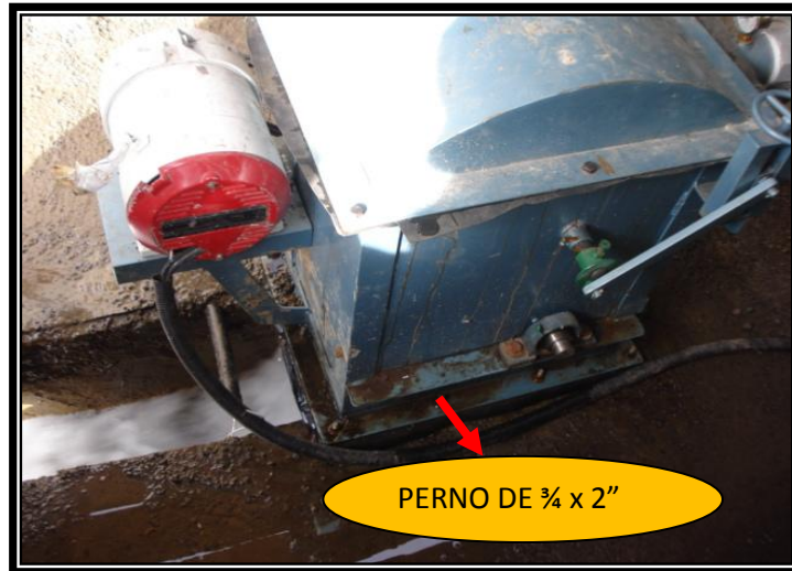
Fig. No. 3.28 Cimentación de la turbina
