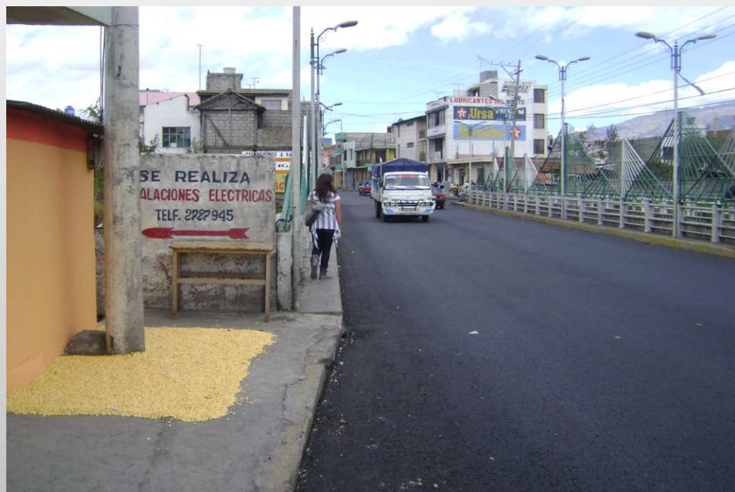
ENTRADA PRINCIPAL A LA CIUDAD, PUENTE "COMPADRE HUAICO"
