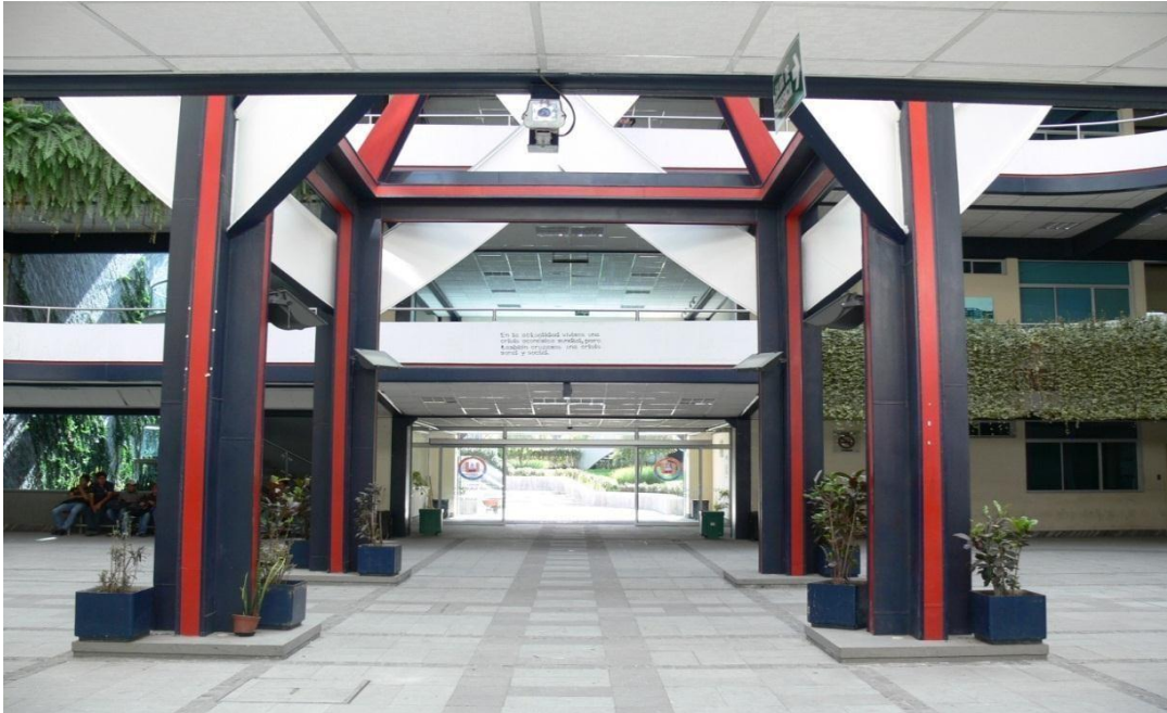
Anexo 5.- Vista interna del Bloque “B”
