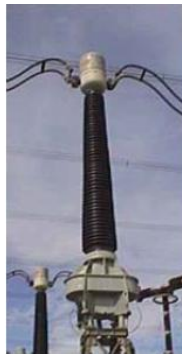
FIGURA 1.19. IMAGEN DE UN TRANSFORMADOR DE CORRIENTE
