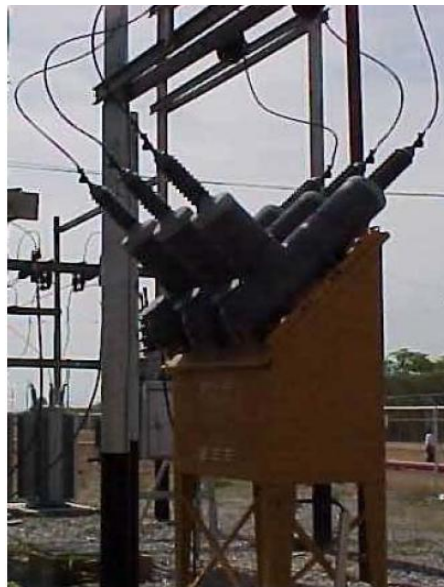
FIGURA 1.18. IMAGEN DE UN INTERRUPTOR DE POTENCIA
