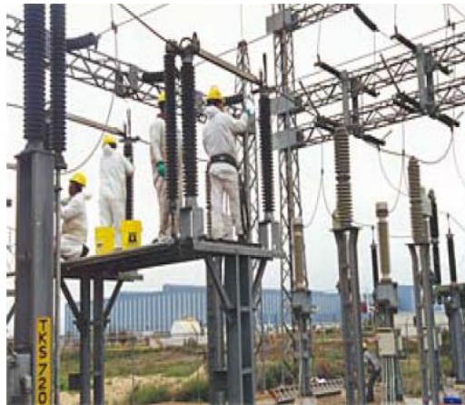
FIGURA 1.17. IMAGEN DE UN SECCIONADOR
