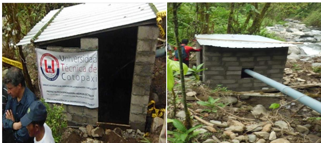
Figura 3.9. VISTA EXTERIOR DE LA CASA DE MÁQUINAS
