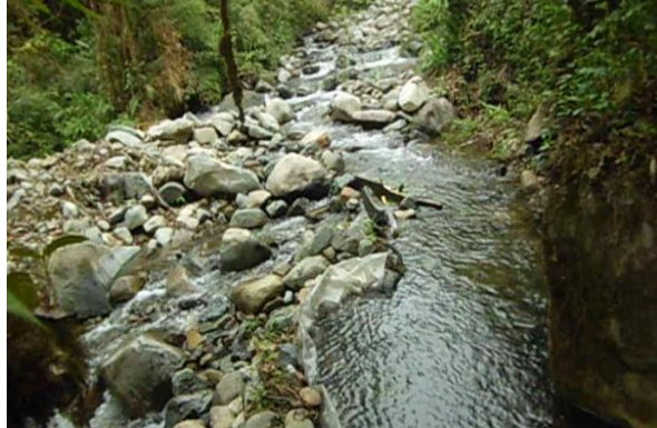
Figura 3.2. GAVIONES DE LA BOCATOMA
