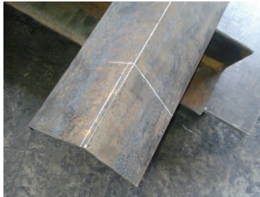
FIGURA 3. 65. CONSTRUCCIÓN DE LA BASE
