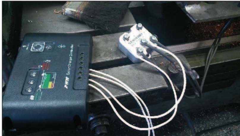
Figura 3.31. Funcionamiento prueba electrónica.
