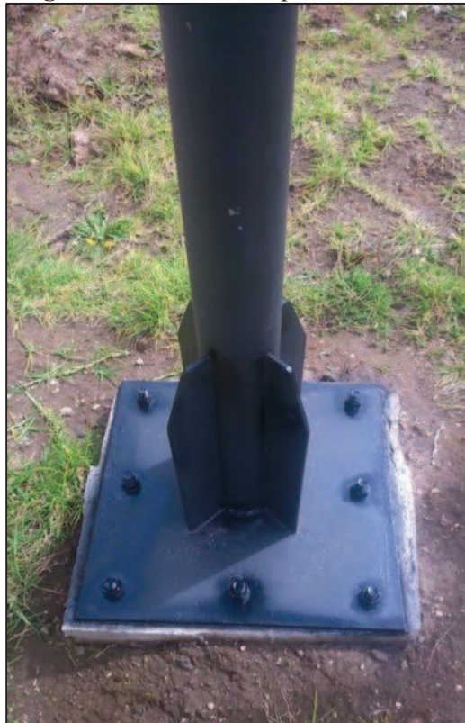
Figura 3.25. Base de soporte de la torre.
