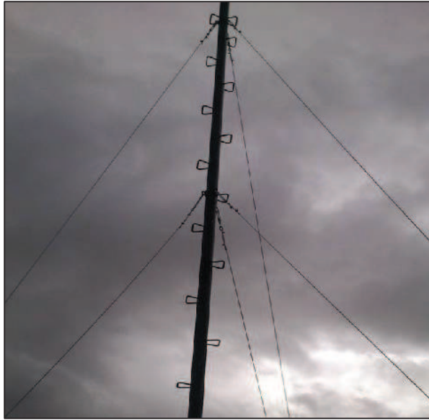
Figura 3.27. Instalación de los tensores.
