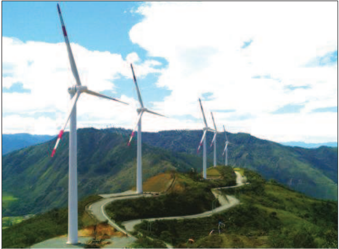
Figura 1.6. Parque eólico villonaco Loja-Ecuador.
