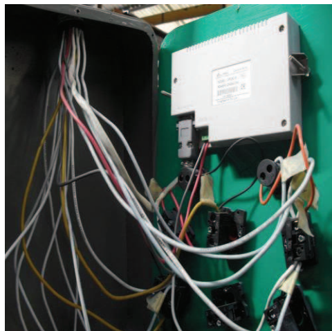
FIGURA 3.40 CABLEADO DEL PANEL OPERADOR
