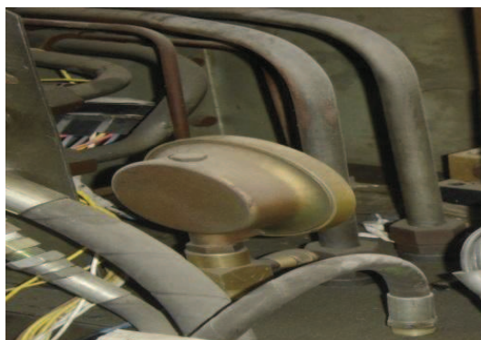
FIGURA 3.27 TUBERÍAS Y MANGUERAS
