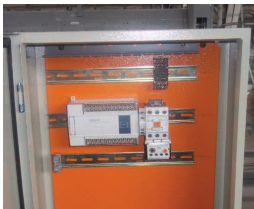
FIGURA 3.35 MONTAJE DEL PLC
