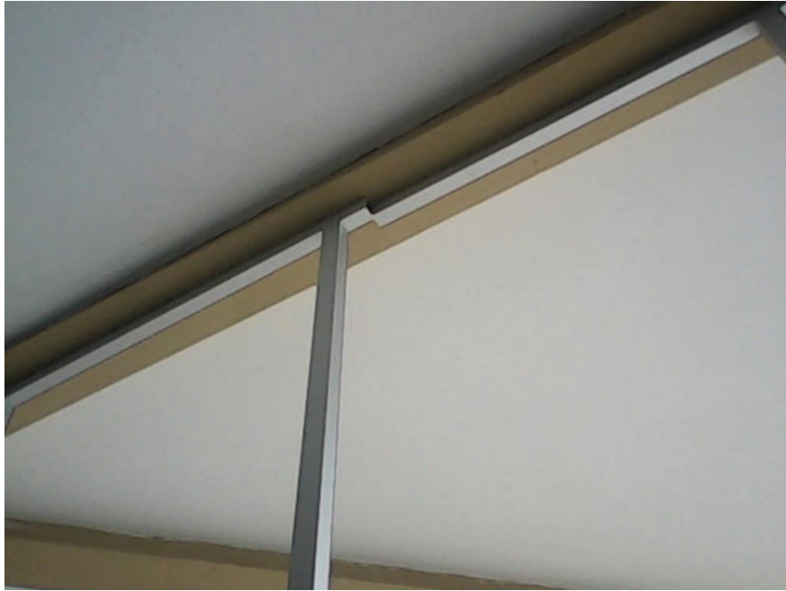
Ilustración 3: Marcos de aluminio mal ensamblado
