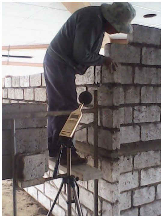
Ilustración 2: Trabajador pegando Bloque
