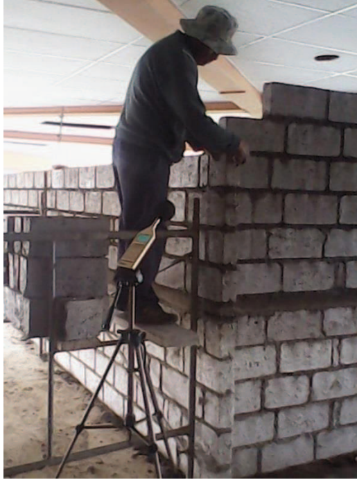
Ilustración 1: Pegado de bloque
