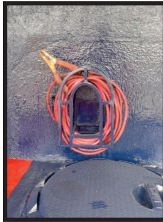
Fotografía No. 4: Pinza a tierra.
