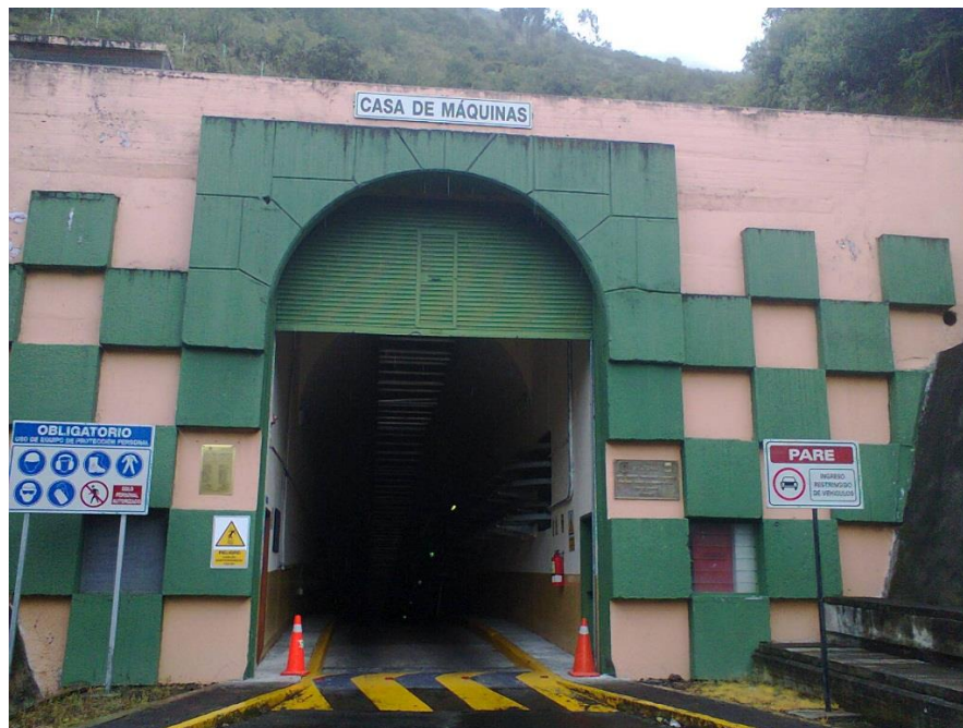
Fuente: Central Hidroeléctrica Pucara.
