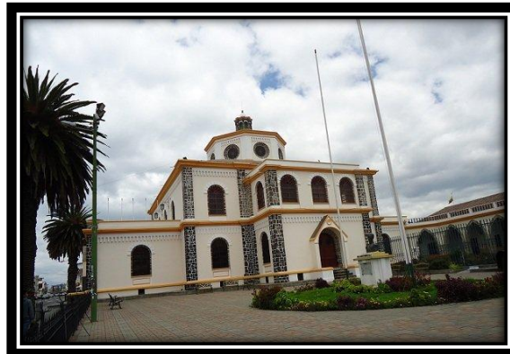
FIGURA N° 19 COLEGIO VICENTE LEÓN PARTE INFERIOR PLANTA BAJA ESQUINA SUR ORIENTAL
