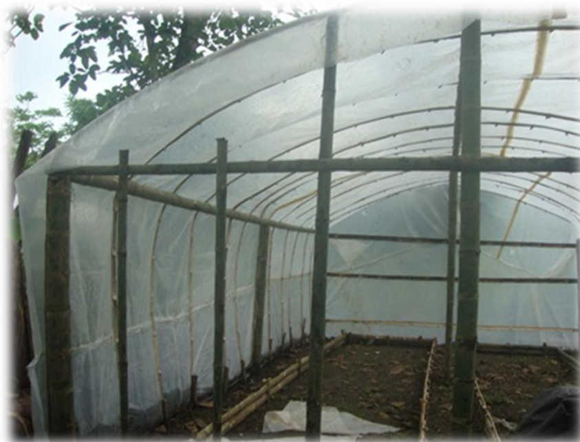
Fotos2. Construcción del umbráculo de 50 y 80% de luminosidad
