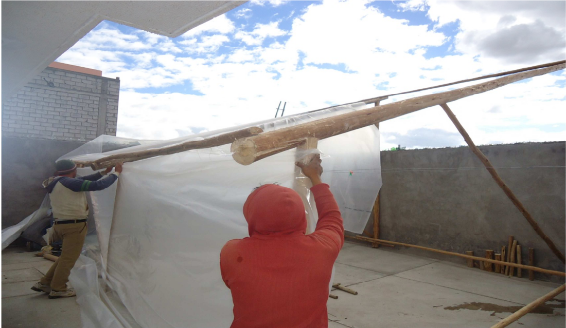
Fotografía N°10.- CONSTRUCCIÓN DEL UMBRÁCULO
