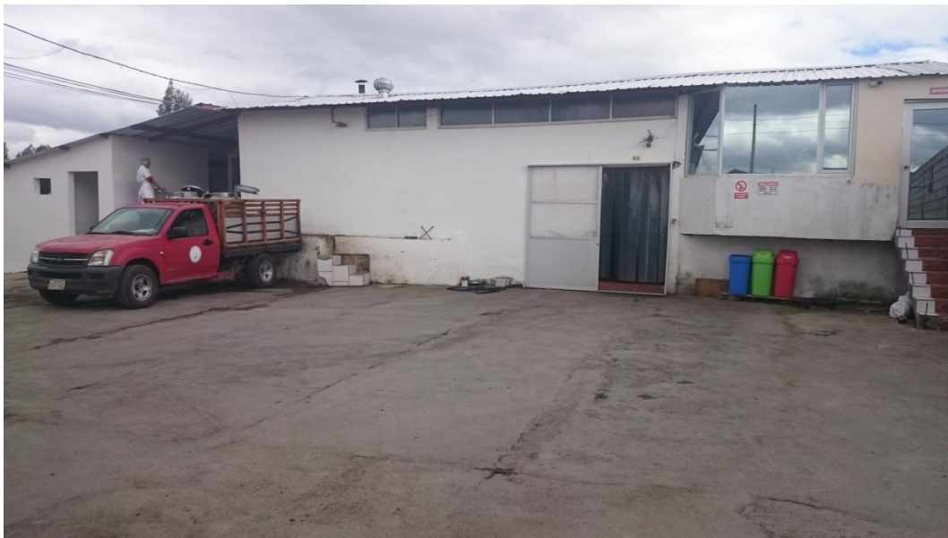
Fotografía 18. Techos y ventanas
