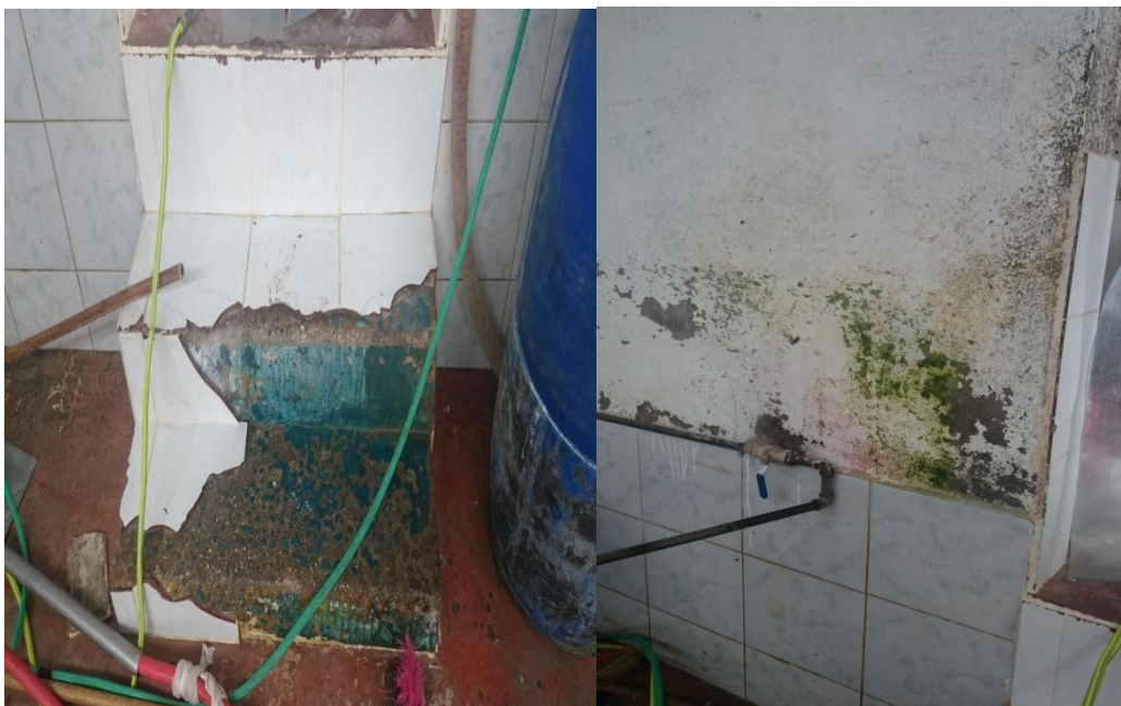
Fotografía 38. Instalaciones eléctricas sin protección y desagües con basura
