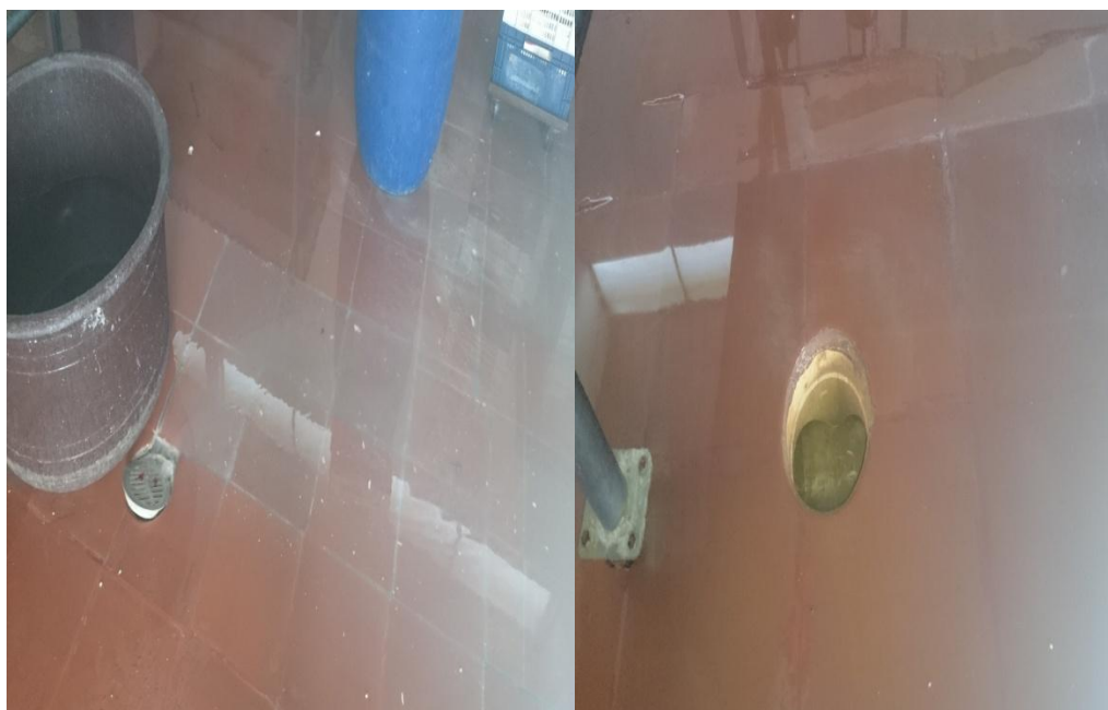
Fotografía 20. Recipientes de desechos y trampas de plagas en mal estado
