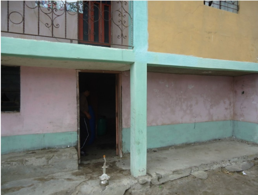
Instalaciones donde se procesa el vino de mortiño
