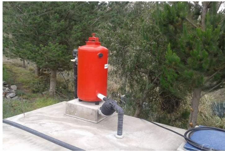
Filtro de grava en el tanque cisterna (modelo 4202)
