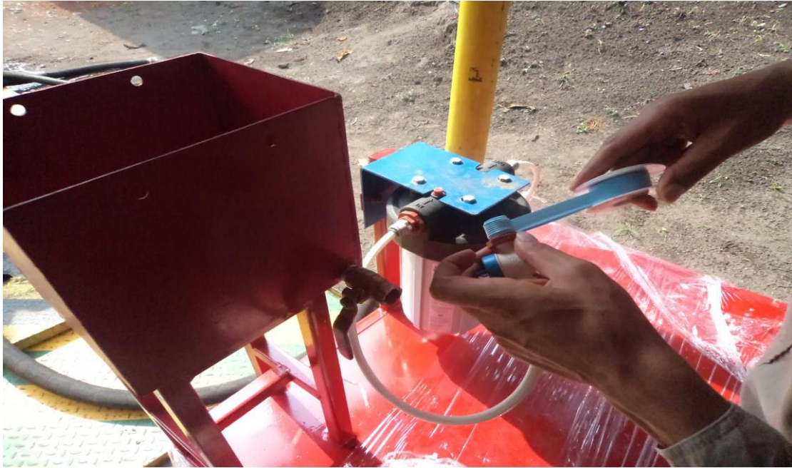
Instalación de conexiones del sistema de filtrado
