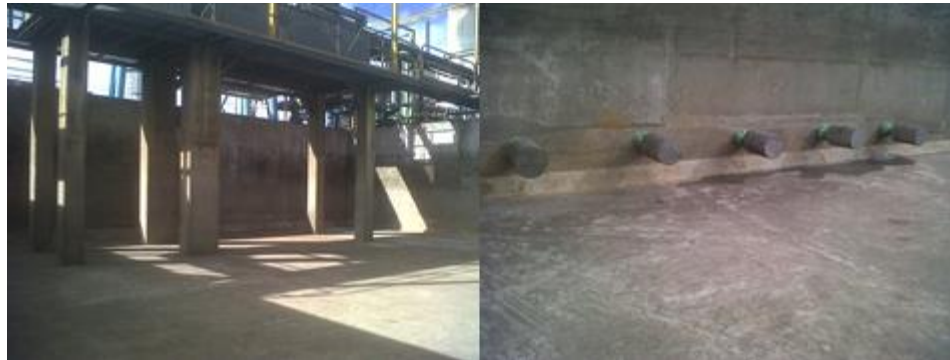
IMAGEN N° 7: Medición de áreas totales
