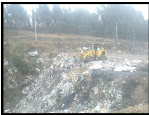
Acomodamiento de los desechos por la maquinaria en la quebrada.
