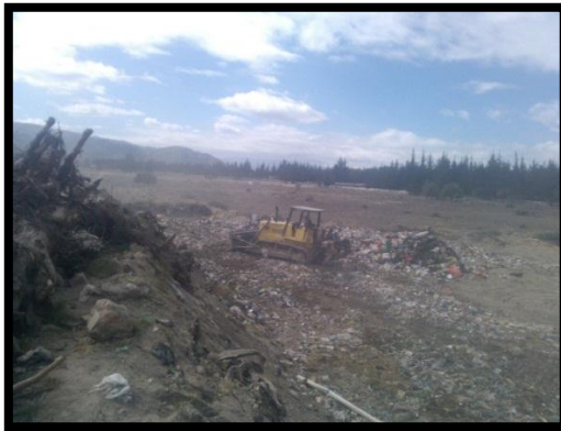
Acomodamiento de desechos por la maquinaria en la zona.
