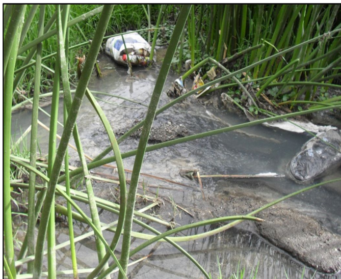
FOTO N° 6. Descarga del primer sistema de alcantarillado de la parroquia Guaytacama.
