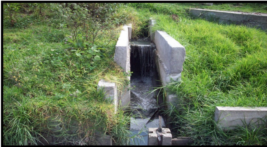
Anexo 2. Fotografía de captación del agua de alcantarillado a la planta de tratamiento. Fuente: Nelly Lescano
