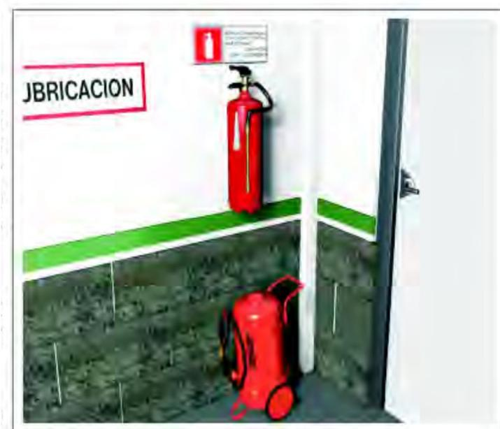
***Figura N°15: Extintores en el área de almacenamiento.***
