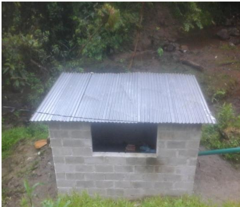
CASA DE MÁQUINAS
