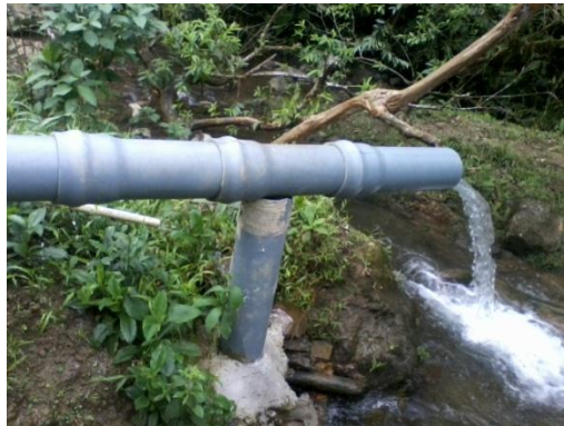
CANAL DE DESCARGA
